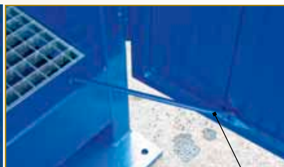
Dispositivo bloccaggio su tutte le porte a battente Doors "blocking" system
